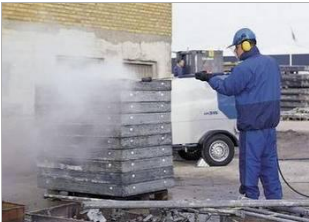
Reinigen von Schalungen
