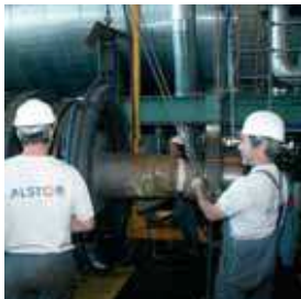
Mitarbeitende von Alstom Field Service im Einsatz
